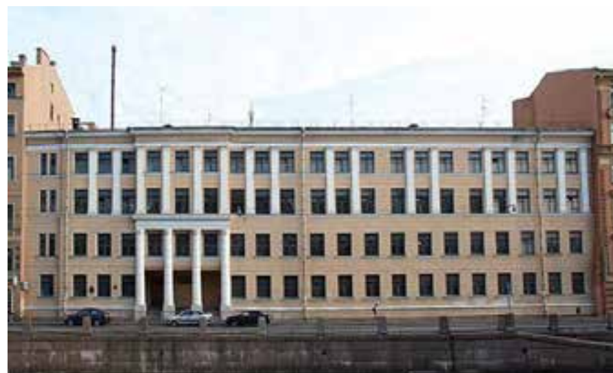
Здание бывшей 22-й школы Октябрьского района, пр. Римского-Корсакова, 69. Арх.: Лебединский Д. Д., Нагорный А. Д.
