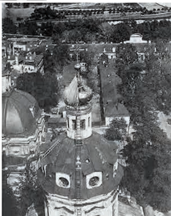
Ил. 19. Снятие маскировочного чехла с купола Никольского собора. 1944
